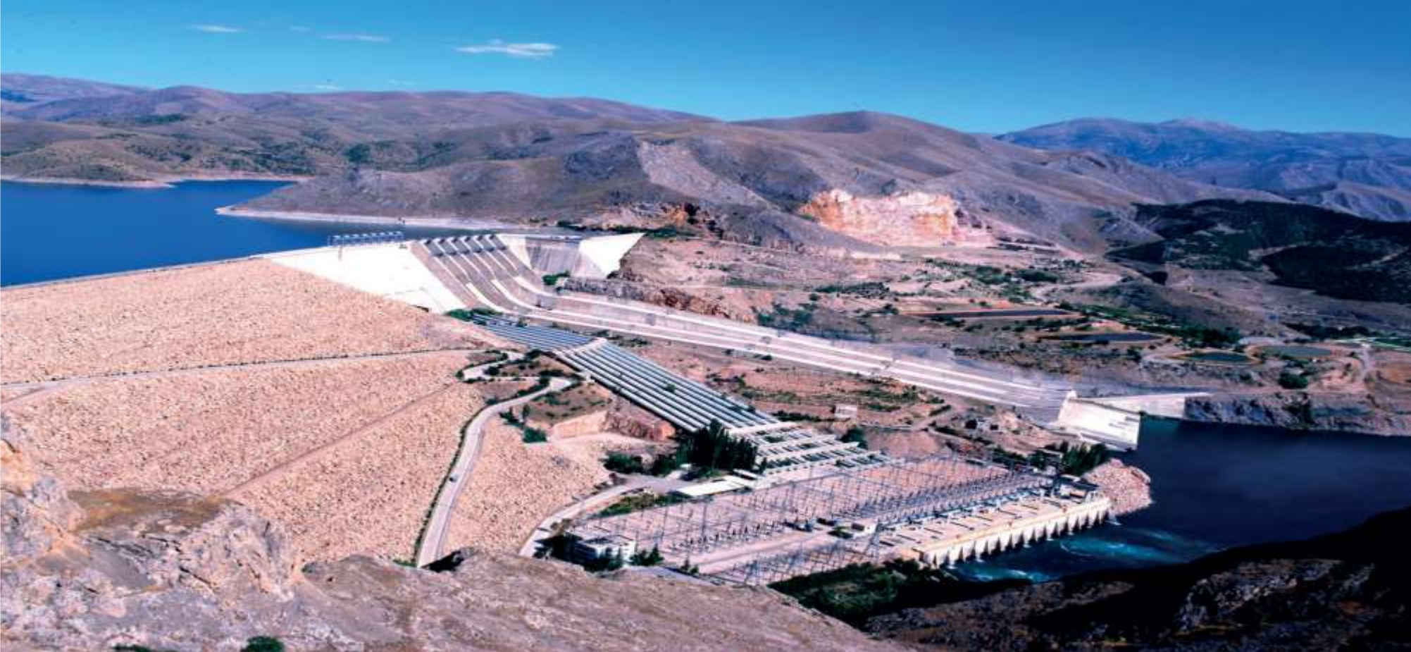
KEBAN Hidroelektrik Santrali
