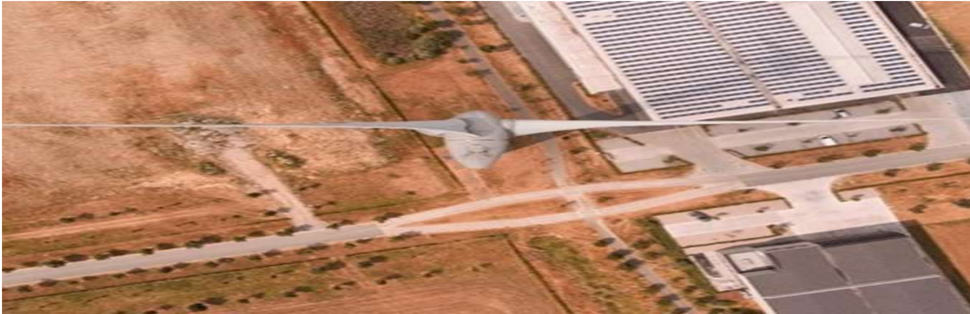
Bütünleşik depolama; Santral Tipi Batarya Enerji Depolama Sistemi
