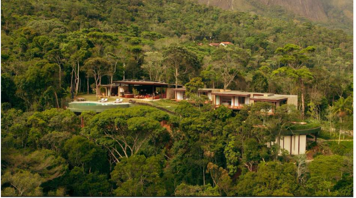
Pedra Azul House / Escala Arquitetura
