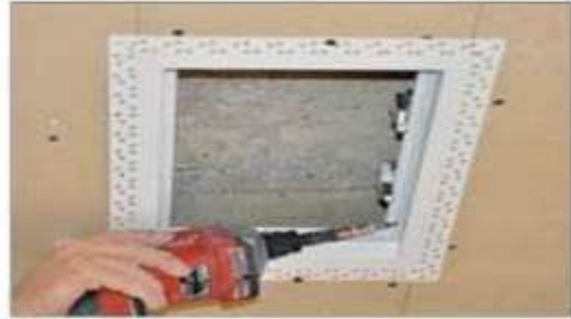
İÇTEN VIDALAMA GÖRÜNÜMÜ INTERNAL SCREWING VIEW
