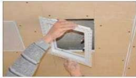
DIŞ ÇERÇEVE YERLEŞİMİ ASSEMBLY OF OUTER FRAME
