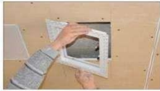
DIŞ ÇERÇEVE YERLEŞİMİ ASSEMBLY OF OUTER FRAME
