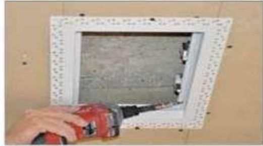
İÇTEN VIDALAMA GÖRÜNÜMÜ INTERNAL SCREWING VIEW
